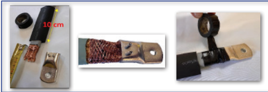
LICON ALT UÇ TERMİNALİ hazırlık çalışmaları LICON LOWER END TERMINAL preparation work
